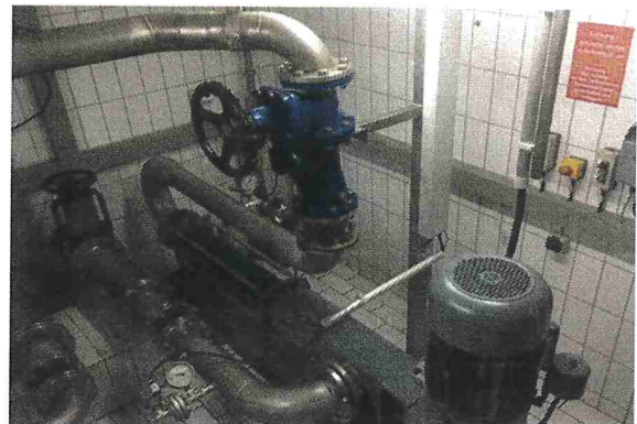
Abb. 1: Eingebaute Exzentrerschneckenpumpe (Fa. Netzsch)
