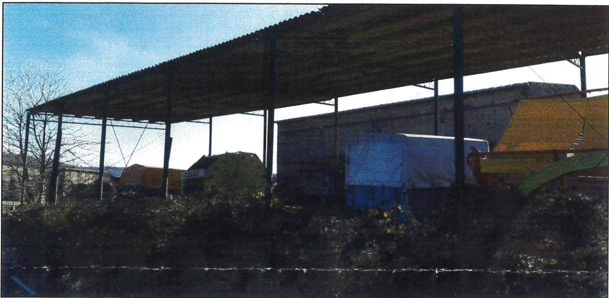
Der gesamte Bereich hinter der Feldscheune sieht ungepflegt aus, das Dach ist auf der linken Seite defekt und ein Dachkennel fehlt komplett. Einige der Geräte sind u.E. nicht mehr einsatzfähig und gammeln so einfach dahin. Auch die Hochsitze gehören nicht dorthin.
