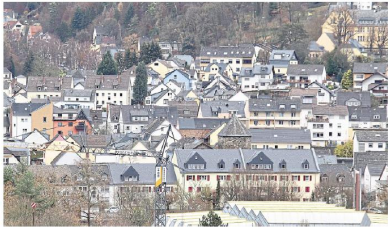
Blick auf Nassau: Viele Häuser haben einen Sanierungsbedarf. Der Stadtumbau öffnet den Weg zu Fördermitteln auch für Private.
