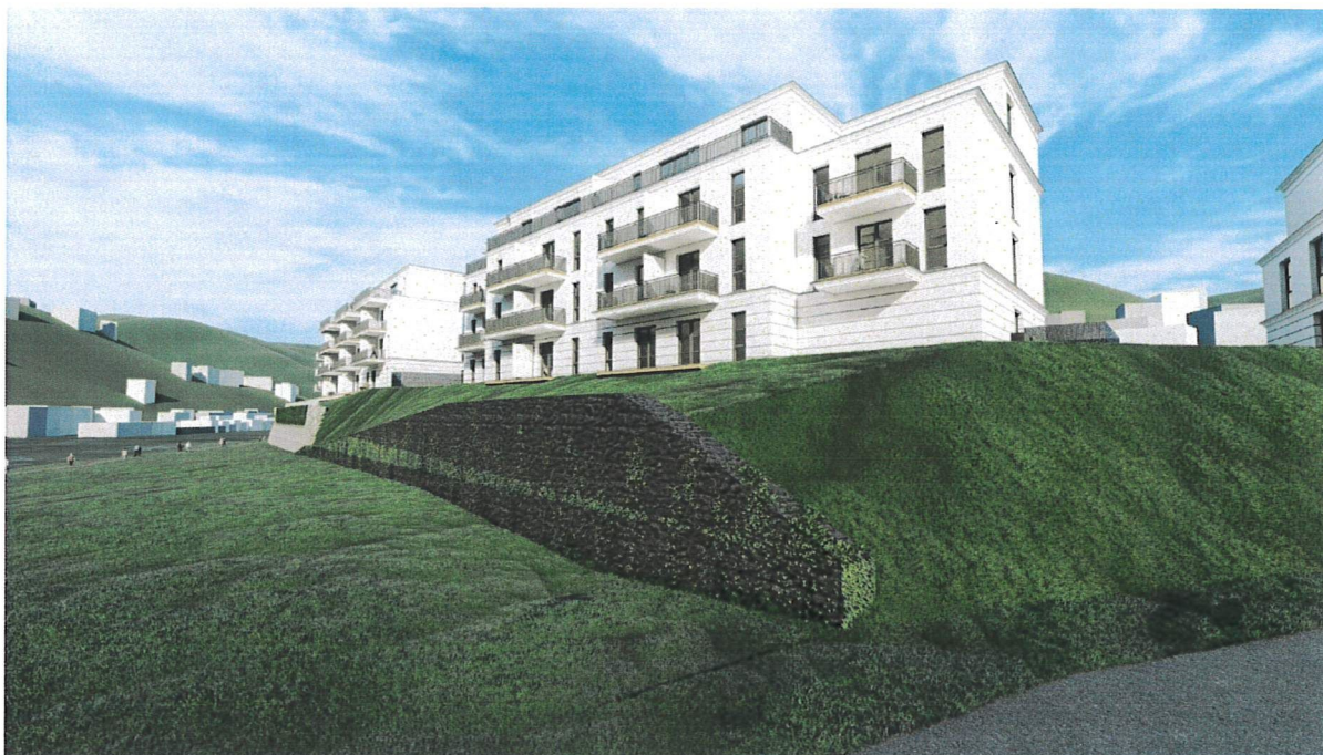
Gabionenwand Bestand – Lahnseite – Bereich Haus D (ohne Bepflanzung)
