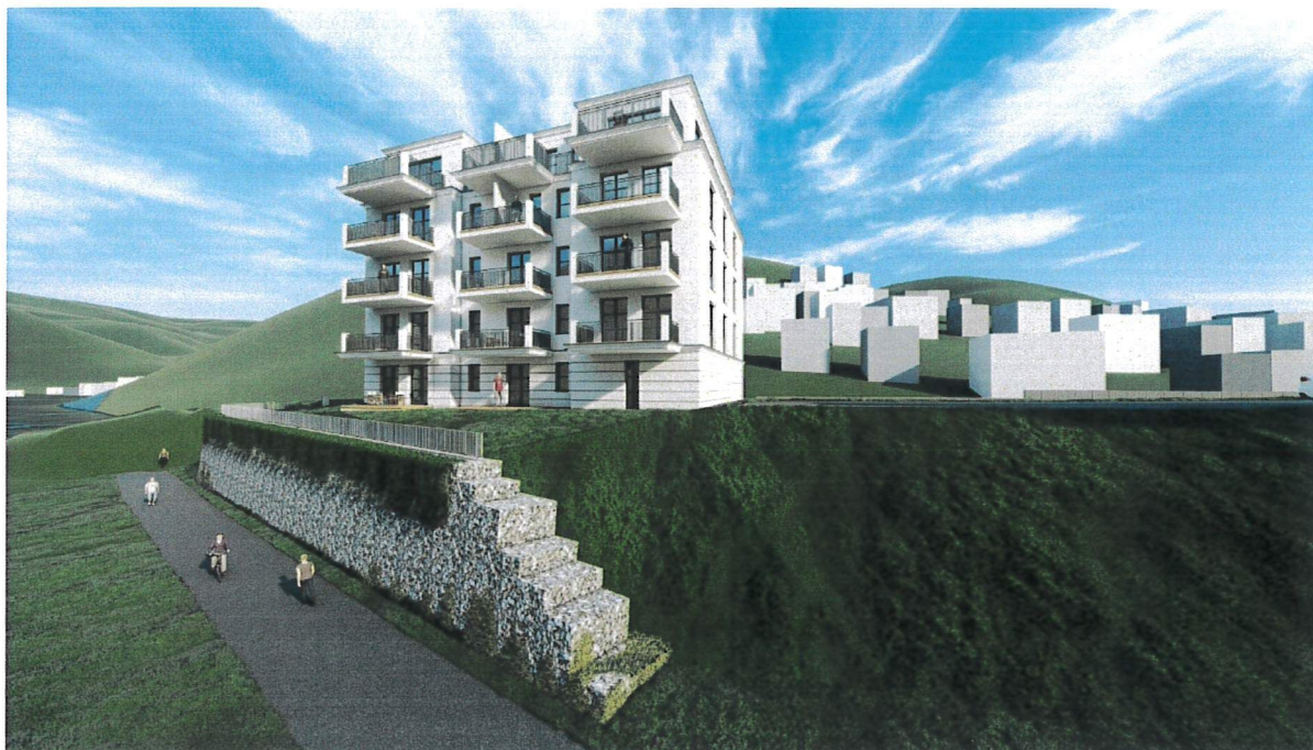
Gabionenwand Neubau – Lahnseite – Bereich Haus A (ohne Bepflanzung)
