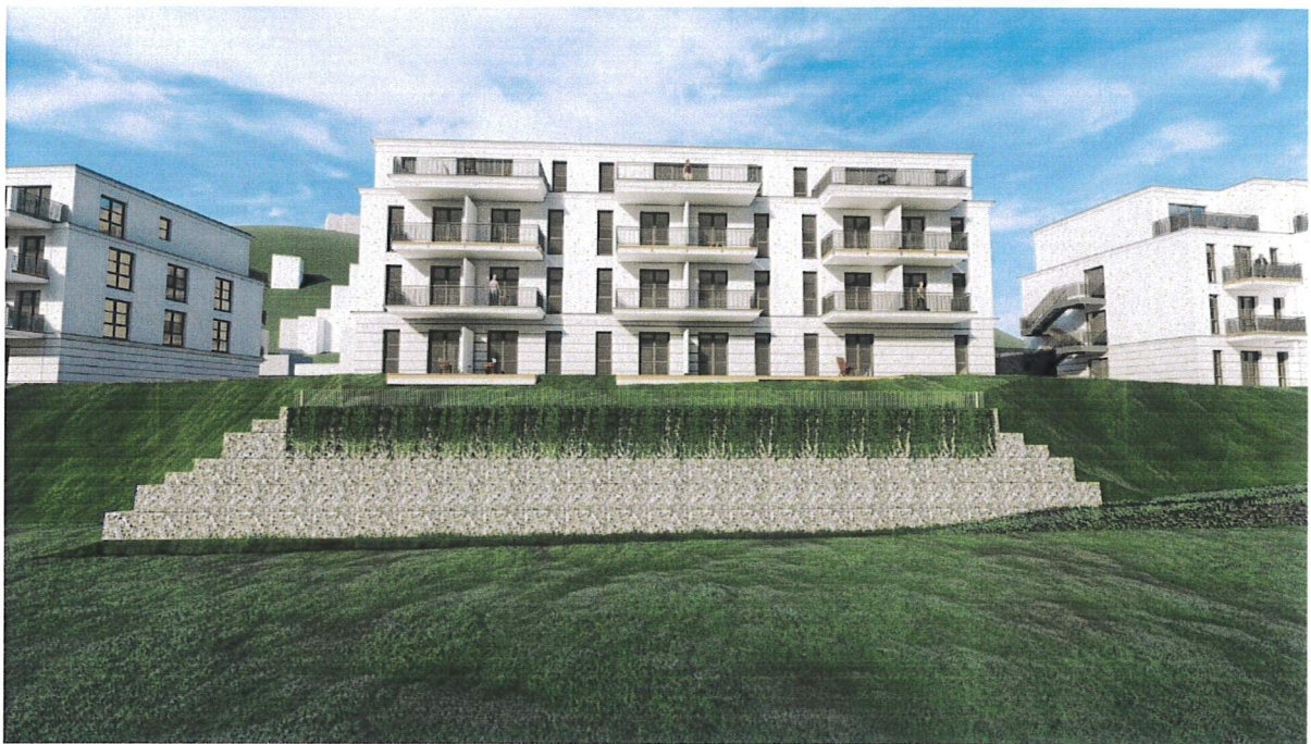
Gabionenwand Neubau – Lahnseite – Bereich Haus D (ohne Bepflanzung)
