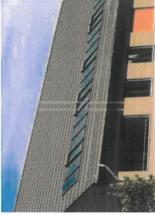
Kollektoren möglichst in die Dachfläche integrieren
