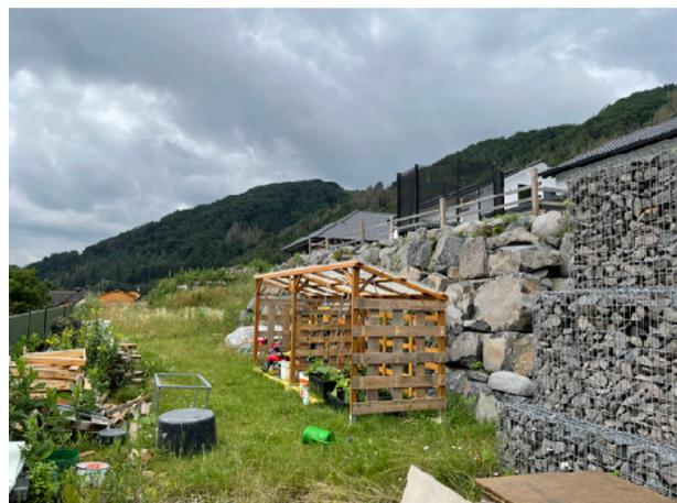
Die Erdanschüttungen wurden mit Stützkonstruktionen (Mauern, Gabione, Findlinge, etc.) hergestellt (s. Bilder Juli 2021).
