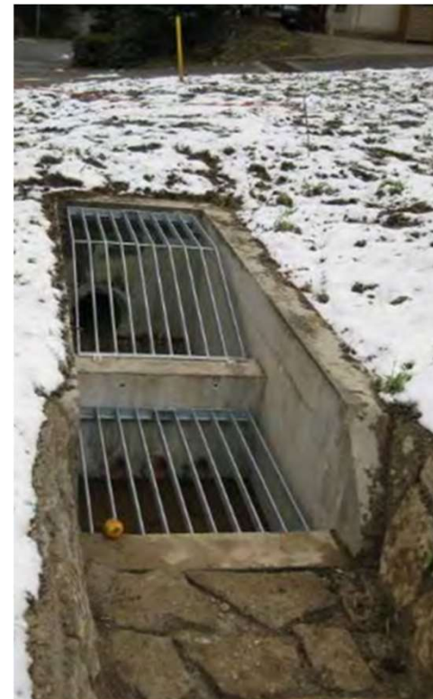
Einlaufbauwerk mit Schlamm- und Geröllfang vor und nach Starkregen
