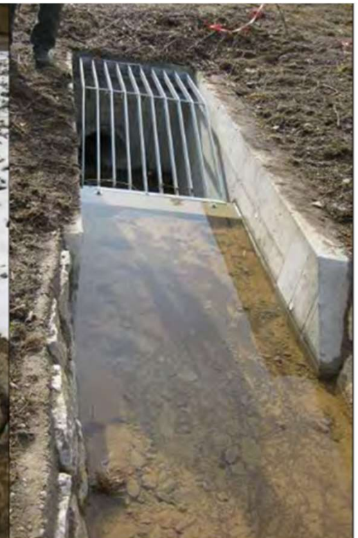
Einlaufbauwerk mit Schlamm- und Geröllfang vor und nach Starkregen
