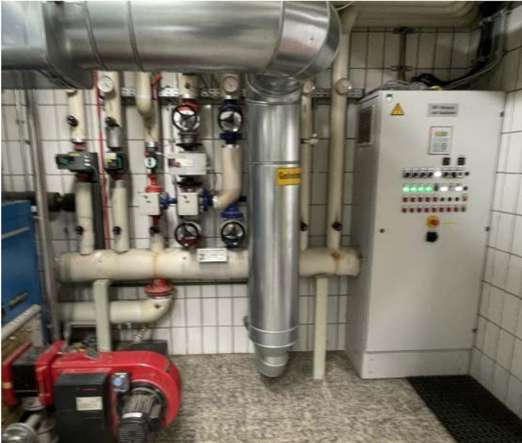
KA Bad Ems - Schaltschrank zur Steuerung der Heizung im Betriebsgebäude
