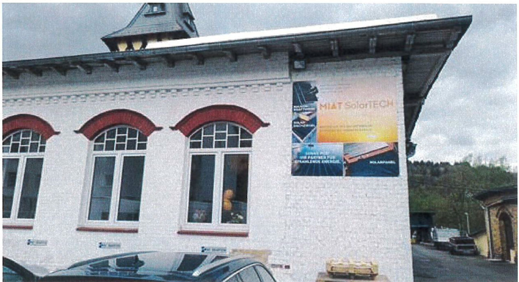
Foto : Standort Werbeanlage 3
