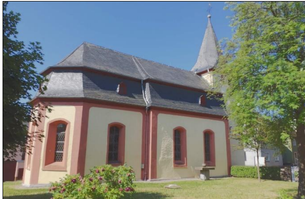
Ev. Pfarrkirche Kirchgasse 2
