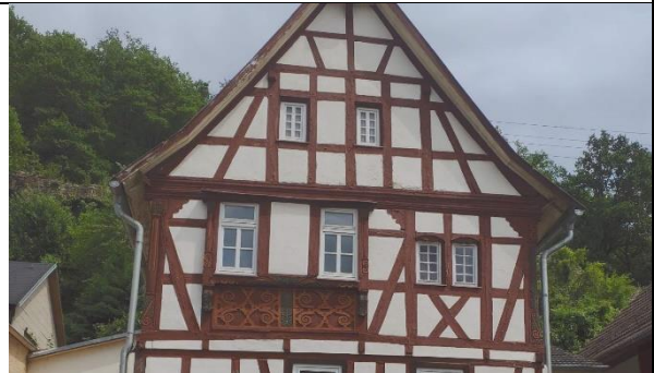
Langgasse 16 Fachwerkhaus mit ehem. Hallenerdgeschoss, bez. 1629
