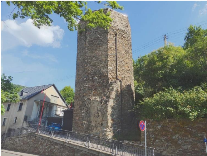
„Schiefer Turm“ Dausenau, (Quelle: eigenes Foto SLP)
