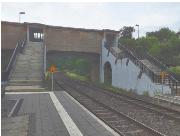
Bahnbrücke Dausenau, (Quelle: eigenes Foto SLP)
