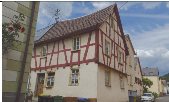
Langgasse 17 Fachwerkhaus, tlw. verputzt, angeblich 1684
