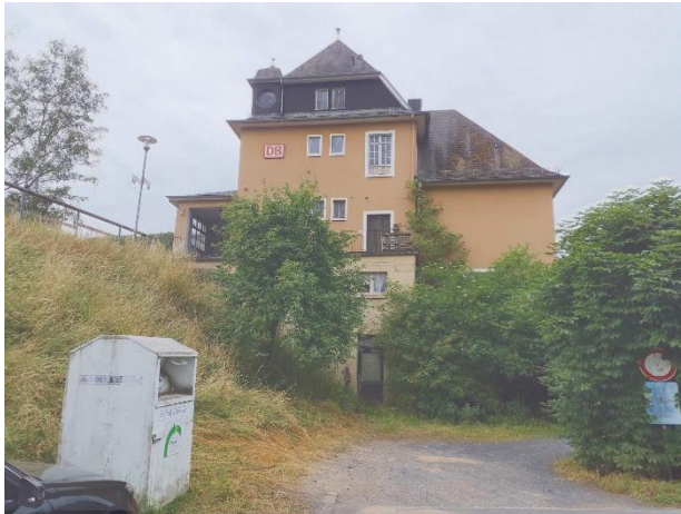
Bahnhofsumfeld Dausenau (Quelle: eigenes Foto SLP)
