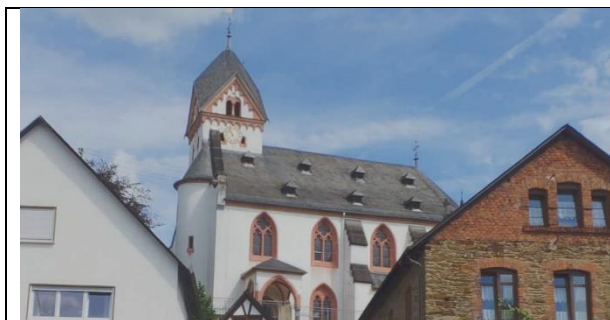
Ev. Pfarrkirche St. Kastor Emporenhalle mit drei Chören, 1. Hälfte 14. Jh., spätromanischer Westturm; auf dem Friedhof Grabmal J. Kurtz († 1824), Bildhauer Josef Scholl, Mainz, ruinös
