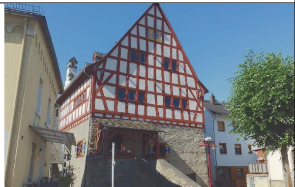
Lahnstraße 22 ehem. Rathaus, spätgotischer Ständerbau, tlw. massiv, 1432/34
