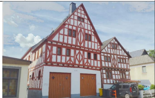
Lahnstraße 8/10 Hallenhaus 16. Jh.
