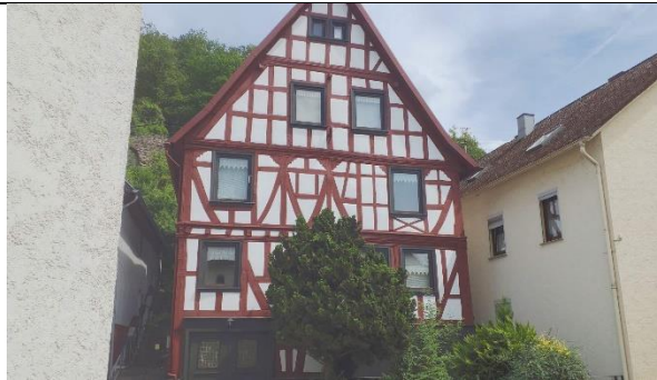
Langgasse 12 Fachwerkhaus mit ehem. Hallenerdgeschoss, um 1600
