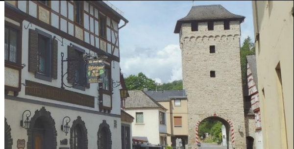
(zwischen) Lahnstraße 2 und 9 Untertor, rechteckiger Torturm der Stadtbefestigung, rundbogige Durchfahrt, Wehrgangsgeschoss, 1324 erwähnt
