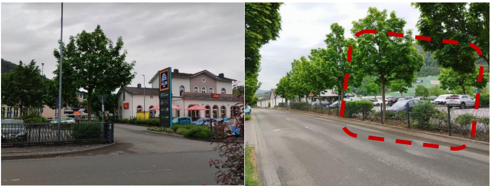
Abbildung 12: Ein- und Ausfahrt des Aldi-Parkplatzes zur Bahnhofstraße im aktuellen Bestand sowie künftiger Bereich¹²
