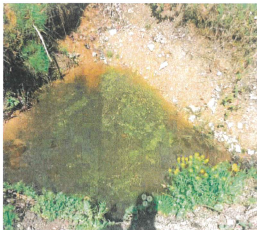
Bild: Auskolkung vor einem Durchlass
