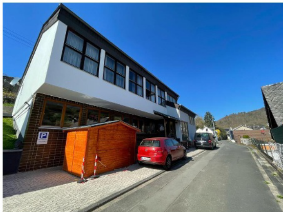
Bestandsgebäude, südlicher Bereich
