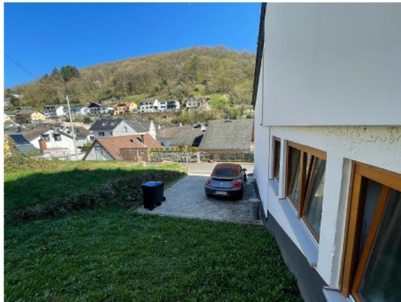
Bestandsgebäude und angrenzende Grünfläche, nördlicher Bereich
