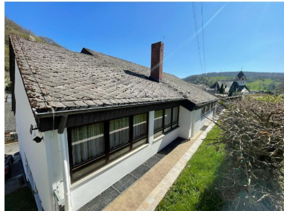
Bestandsgebäude, westlicher Bereich
