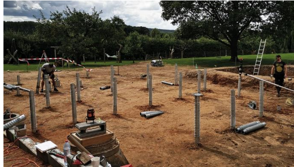
Beispiel einer Schraubpfahl-Gründung, Quelle: Helix-Schraubfundamente
