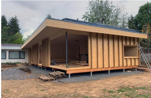
Beispiel einer Schraubpfahl-Gründung, Quelle: Helix-Schraubfundamente
