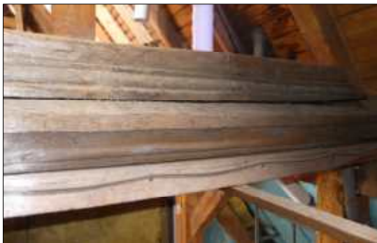
Abb. 7 oben links: Wechsel in der Stichbalkenlage, Giebelwand endet mit Giebelsparren Abb. 8 unten links: Profiliertes Rähm und Schwelle im Dachgeschoss Abb. 9 rechts: Eingezapfter Pfosten der Giebelwand in Giebelsparren
