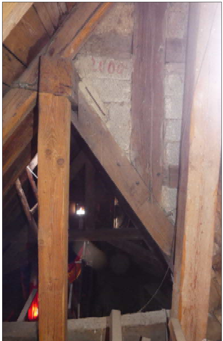
Abb. 7 oben links: Wechsel in der Stichbalkenlage, Giebelwand endet mit Giebelsparren Abb. 8 unten links: Profiliertes Rähm und Schwelle im Dachgeschoss Abb. 9 rechts: Eingezapfter Pfosten der Giebelwand in Giebelsparren
