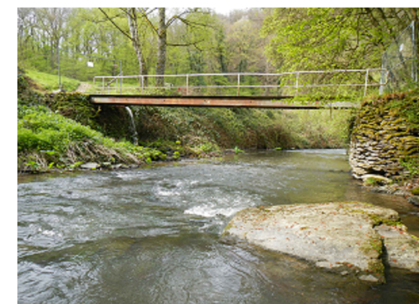
Aufnahme des Bauwerks am 26.04.2023 mittels Zollstock und Maßband (keine vermessungstechnische Aufnahme!)
