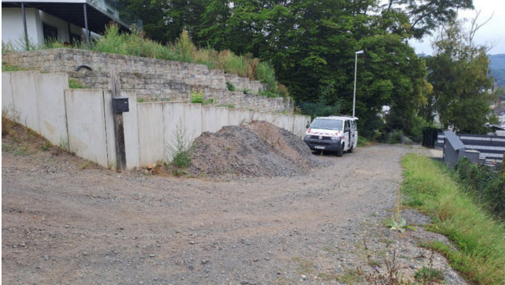
Abbildung 5: Schotterfläche Anwesen Bergstraße 7, Blickrichtung Westen (Eigene Aufnahme)
